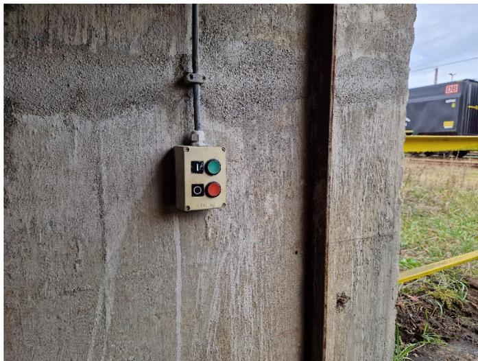
Abb. 4: Lage des Lichtschalters am Ein-/Ausgang im Bereich Ausfahrgruppe – grün - einschalten, rot – ausschalten
