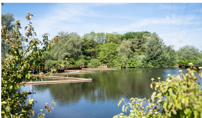
Abbildung 2: Deichpumpwerk mit Beruhigungssee
