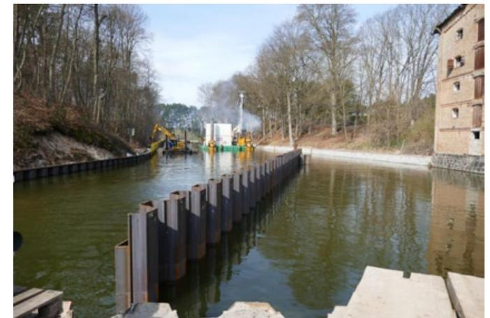
Das Bild oben zeigt Spundwände beim „Neubau der Schleuse Steinhavelmühle“ in Brandenburg. Für das Projekt wurden ArcelorMittal-Spundbohlen der EcoSheetPile™ Reihe verwendet. Diese wiederum sind aus 100 Prozent Stahlschrott gefertigt.
