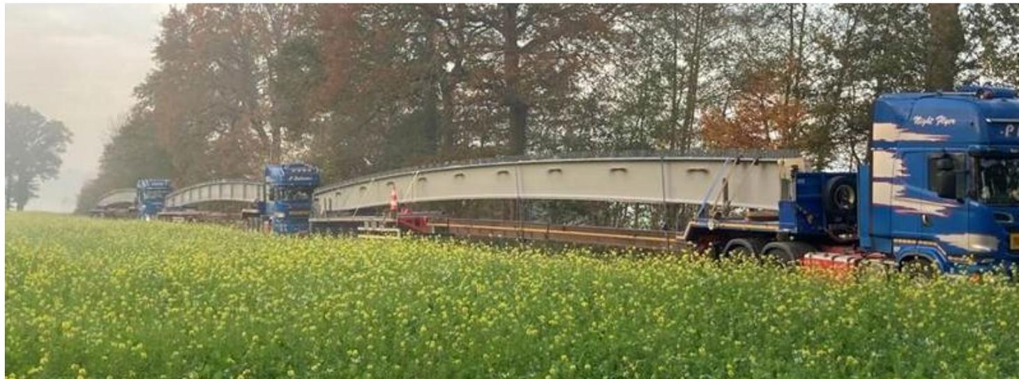
In der Nacht erfolgte der Startschuss für den Ersatzneubau: Drei Schwertransporte lieferten die gigantischen Brückenträger als Sondertransport auf die Baustelle – der Einsatz verlief komplikationsfrei. Nach kurzer Endmontage, die im Laufe des Vormittags stattfand, konnte die Brücke eingelegt werden.
