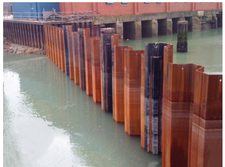
Abb. 13 Hafen von Shoreham, AMLoCor Stahlsplundwand
