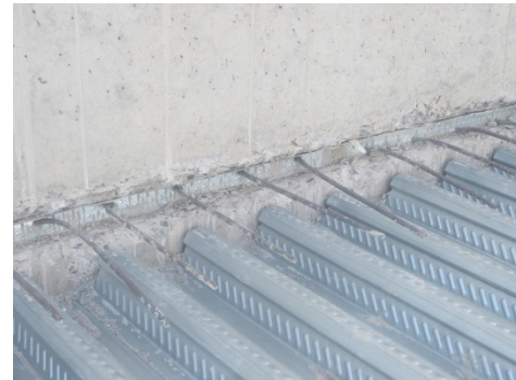
Fertig zum Vergießen: Schwimmende Auflagerung mit Anschlussbewehrung
