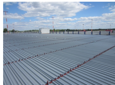
Schalung und Bewehrung in einem: Die COFRASTRA-Verbunddecken-Profile ermöglichen effektiveres und leichteres Bauen. Hier COFRASTRA 40 im Einfeldsystem mit Profilfüller in der Parkdeck-Sanierung.
