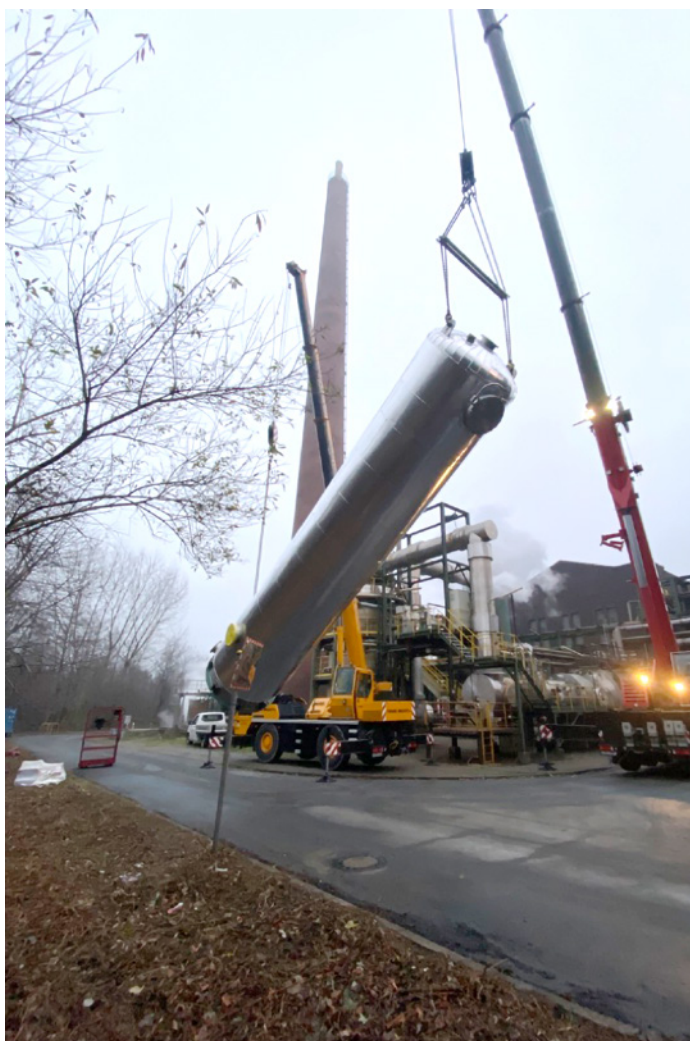
Bei der Anlieferung des Entsäurers war schweres Gerät im Einsatz
